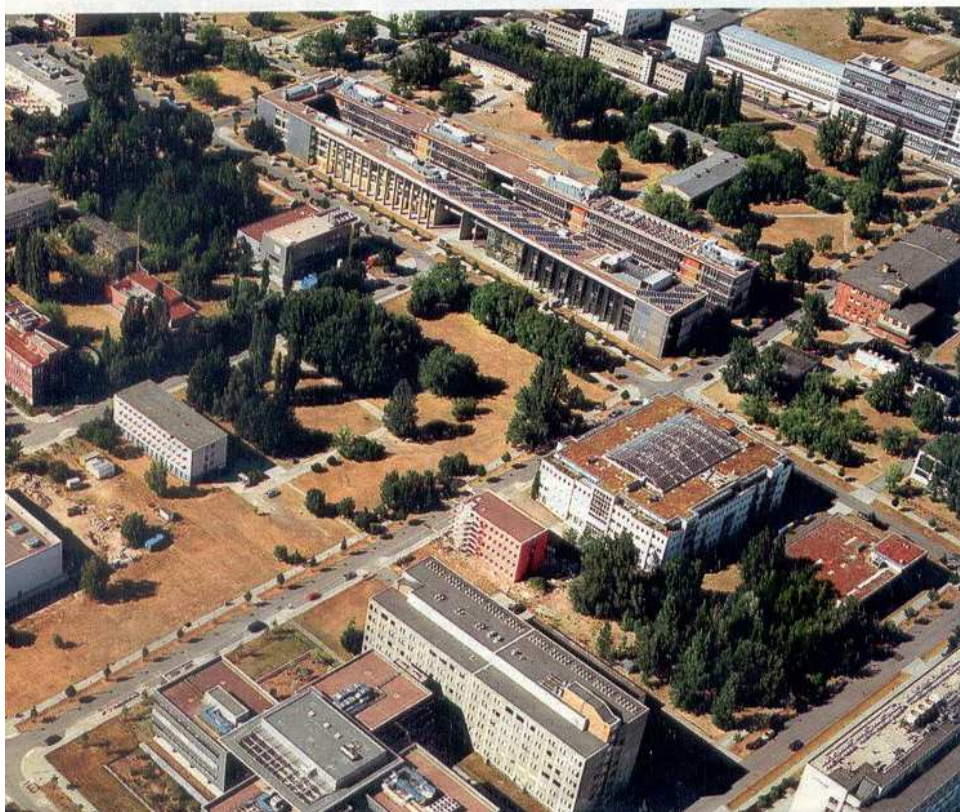
Technologiepark Berlin-Adlershof Stabiles Netzwerk aus alten Tagen
